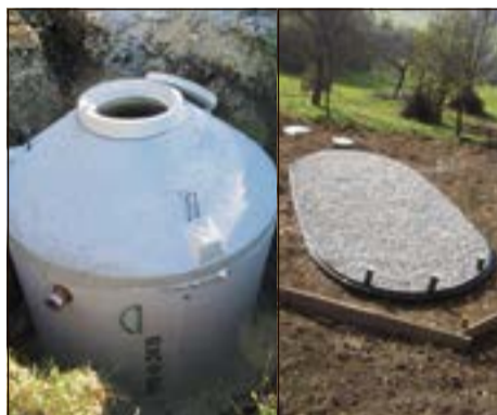
Primer izgradnje male komunalne čistilne naprave
